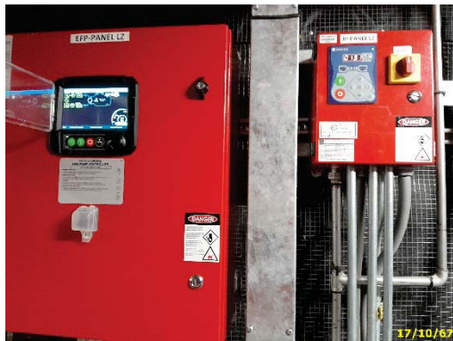
เครื่องสูบน้ำดับเพลิง High Zone, Low Zone และตู้ควบคุมการทำงาน
