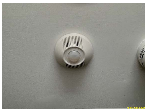
ระบบ Light Sensor ภายในห้องน้ำ
