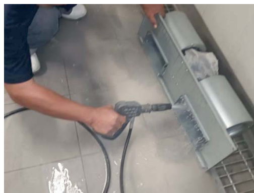
ดูแลตรวจสอบ และการล้างเครื่องปรับอากาศ
