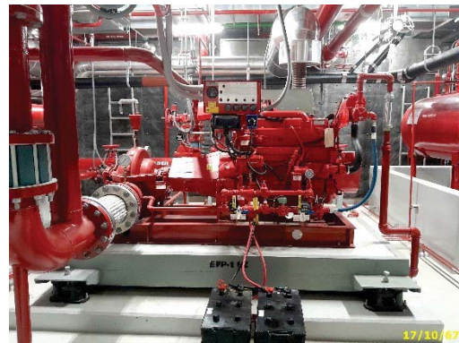
เครื่องสูบน้ำดับเพลิง High Zone, Low Zone และตู้ควบคุมการทำงาน
