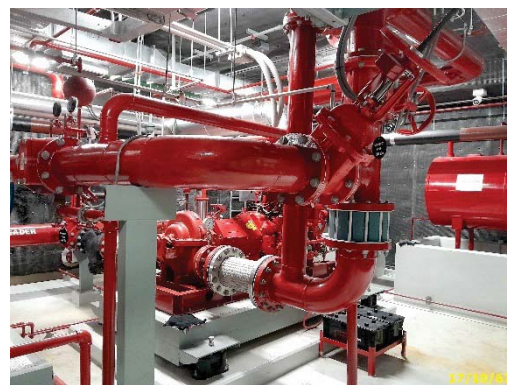
เครื่องสูบน้ำดับเพลิง High Zone และ Low Zone และท่ออื่น
