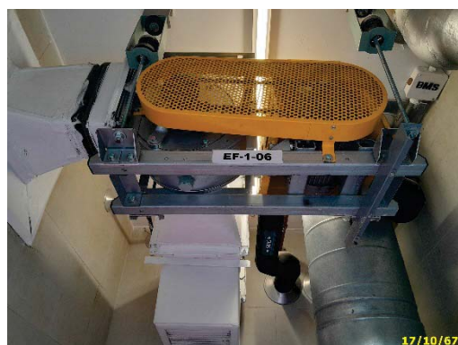
พัดลมดูดอากาศและระบายอากาศ
